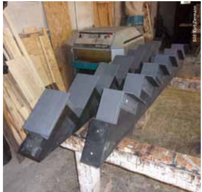
Die Auflager der Auftritts Bretter sind inklusive Stahlwinkel mit Flüssigkunststoff umhüllt worden. Eine Durchdringung der ausgesägten Wange an der Oberseite war damit nicht erforderlich. Auch das vertikale Hirnholz zwischen den beiden Stufen wurde abgedichtet.
