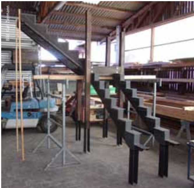
Die Treppe wurde vorab in der Werkhalle aufgebaut. Die Fußpunkte der Stützen wurden noch in der Werkstatt eingedichtet, die restlichen Eindichtungen erfolgte nach Einbau vor Ort.
