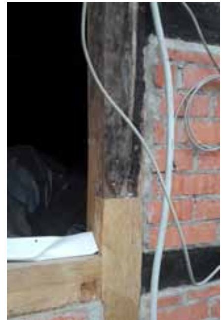
Die verfaulten Hölzer wurden dort, wo möglich, nicht komplett ersetzt, sondern es wurde nur das schadhafte Holz entnommen. Neues Holz wurde dann mit traditionellen Holzverbindungen, wie hier mit einem gerade Blatt, an das verbleibende angeschlossen.
