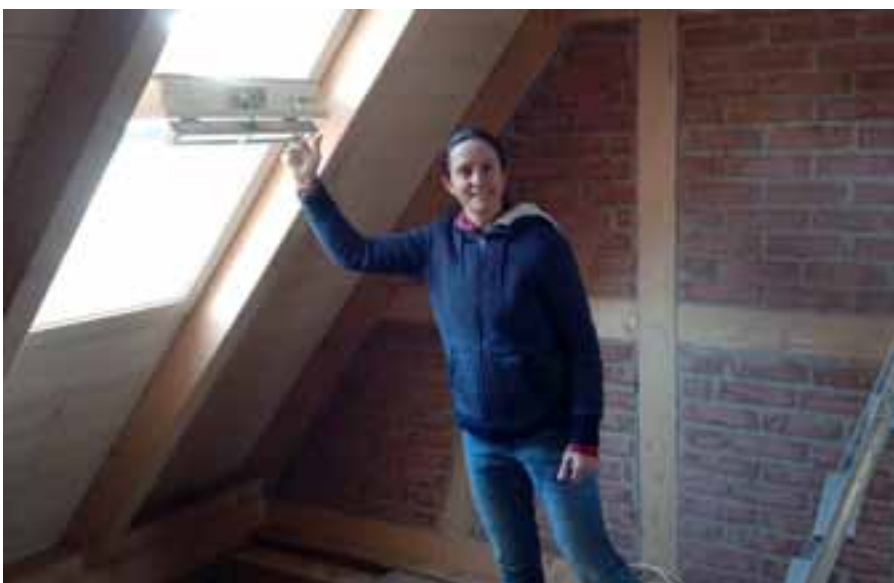
Zimmermeisterin Ruth Wittmann und ihr Team bauten mehrere Dachfenster ein, die Licht in den jetzt genutzten Dachraum bringen.
